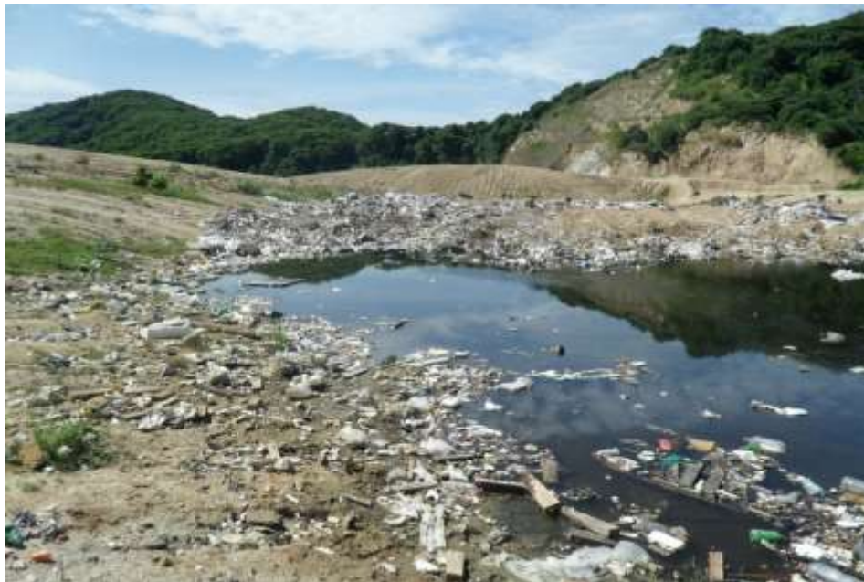
Laguna de evaporación de lixiviados sin impermeabilización. SDF de Acapulco, Guerrero, México. Foto: Juárez-López, (2014).
