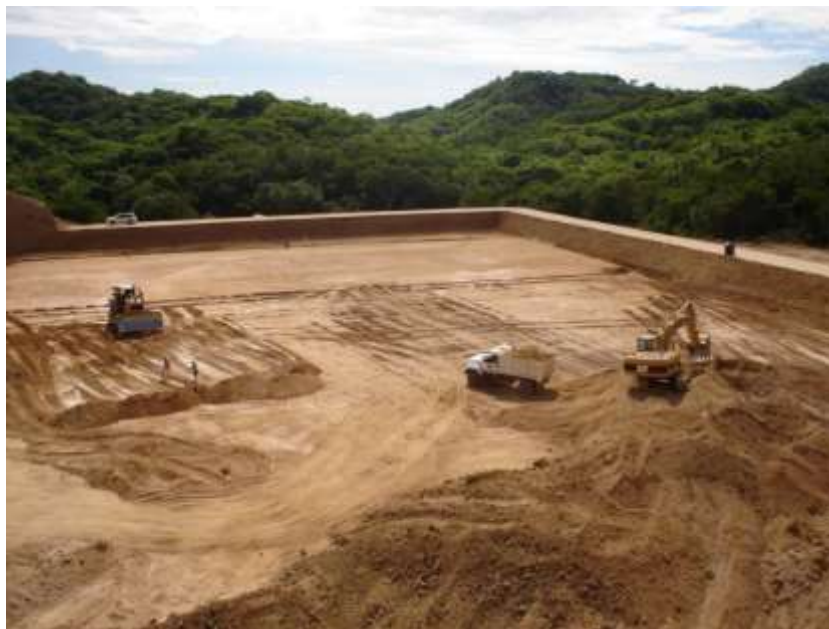
Nivelación de terracerías para la construcción de la celda 2, utilizando motoconformadora y vibrocompactador. SDF de Acapulco, Guerrero, México. Foto: H. Ayuntamiento de Acapulco, (2004).
