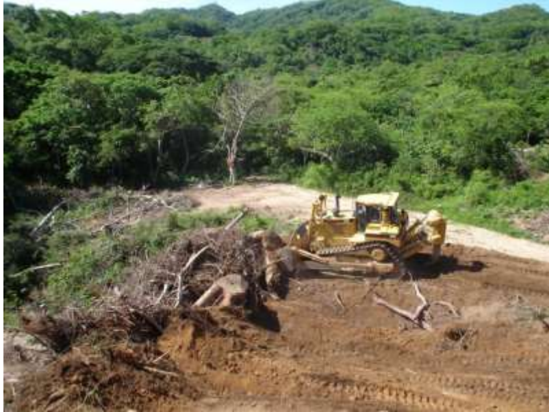
Desmote y despalme de 3.5 hectáreas de cubierta vegetal para la construcción de la celda 2. SDF de Acapulco, Guerrero, México. Foto: H. Ayuntamiento de Acapulco, (2004).
