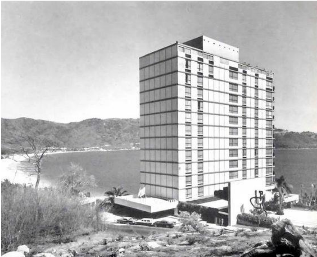
FIGURA 3.24 FOTOGRAFÍA DE LA CONSTRUCCIÓN DEL HOTEL PRESIDENTE 1959
