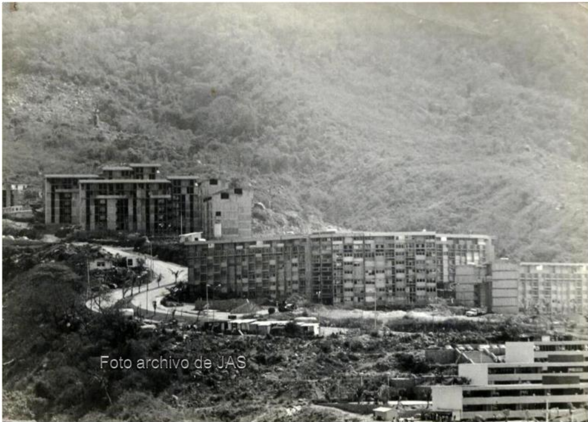
FIGURA 3.29 CONSTRUCCIÓN DE INFONAVIT ALTA PROGRESO
